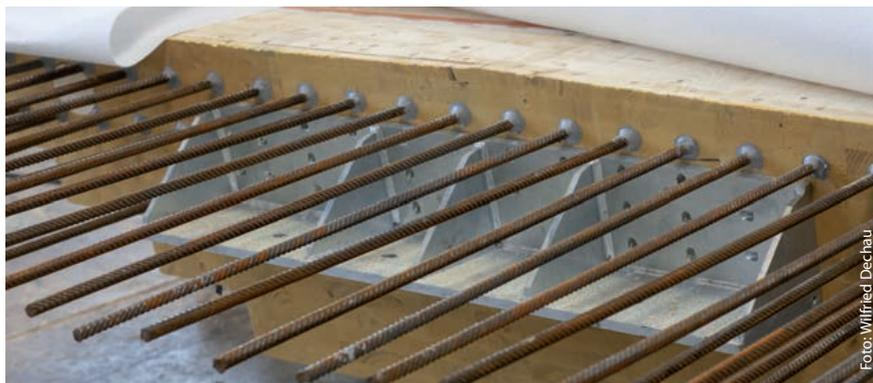
Der biegesteife Anschluss ist durch in das Brettschichtholz eingeleimte Gewindestangen ausgebildet, die mit dem Stahlbetonwiderlager vergossen werden.
