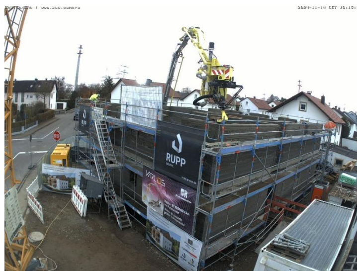
Abb. 8: Druck der letzten Lagen des Gebäudes in Vöhringen
