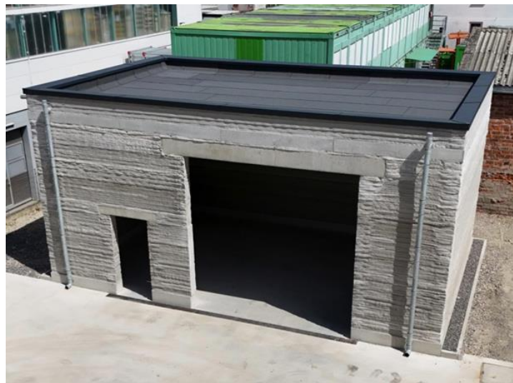
Abb. 7: Rohbau des Gebäudes in Weilimdorf
