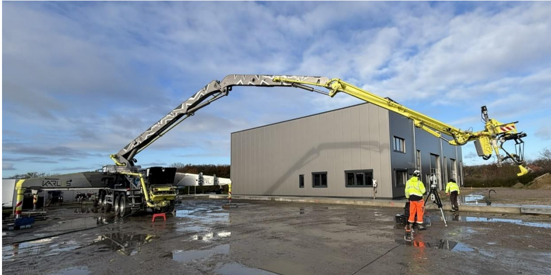
Abb. 1: Der mobile 3D-Betondrucker KARLOS
