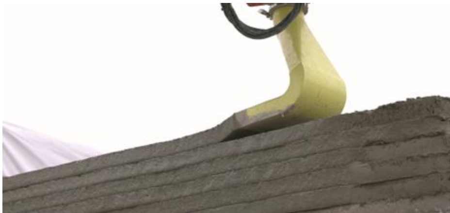
Abb. 2: Ablage eines Betonstrangs mit einer Höhe von 55 mm und Breite von 250 mm
