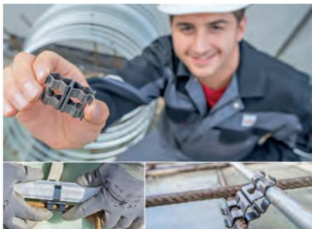
Der „Dehn Clip“ kann schnell montiert werden und ist blitzstromgeprüft.
