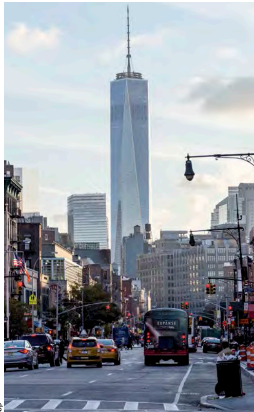
Ein Ingenieurbauwerk für sich: die 134 m hohe Antenne der „Krone des One World Trade Centers“.
