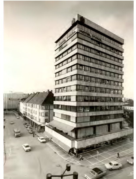
1 Vor der Modernisierung: Das 1973 errichtete Sparkassen-Hochhaus besaß eine Bandfassade mit eher trister Natursteinbekleidung im Brüstungsbereich.
