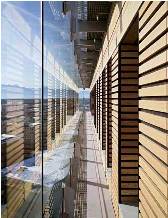
4 Zwischen der Holzfassade und der äußeren Glashaut befindet sich ein 60 cm breiter Zwischenraum, der verschiedene Aufgaben erfüllt: Die Doppelfassade unterstützt mithilfe eines ausgeklügelten Lüftungsklappensystems die Regulierung des Raumklimas in den Büros. Im Brandfall bilden auf den Gitterrost des Wartungsgangs umgelegte Lüftungsklappen zusammen mit den Stahlblechabdeckungen Rauchschotts. Oben im Bild: die Sprinklerköpfe.
