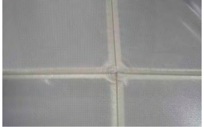
Abb. 15: Kreuzungspunkt von außen
