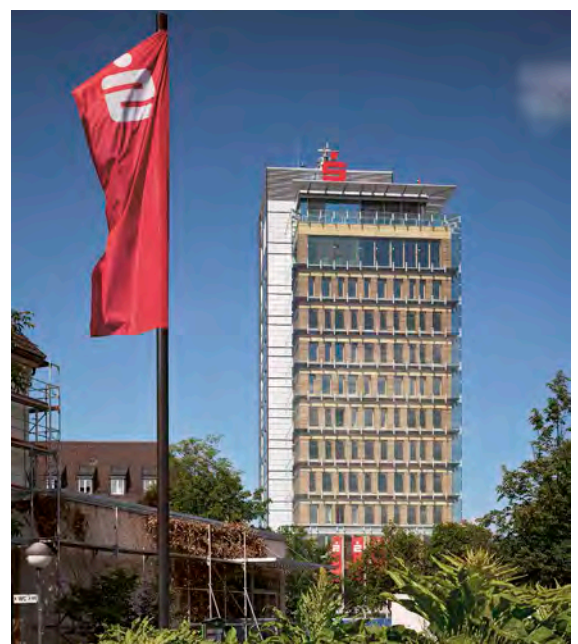
6 Die beiden oberen Etagen sind neu – eine ersetzt und eine aufgestockt. Die aufgesetzte Technikzentrale bildet den oberen Gebäudeabschluss. Die zurückgesetzte 12. Etage – das „Skydeck“ – mit auskragendem Sonnenschutz trägt zum weithin sichtbaren Gesamtbild bei.
