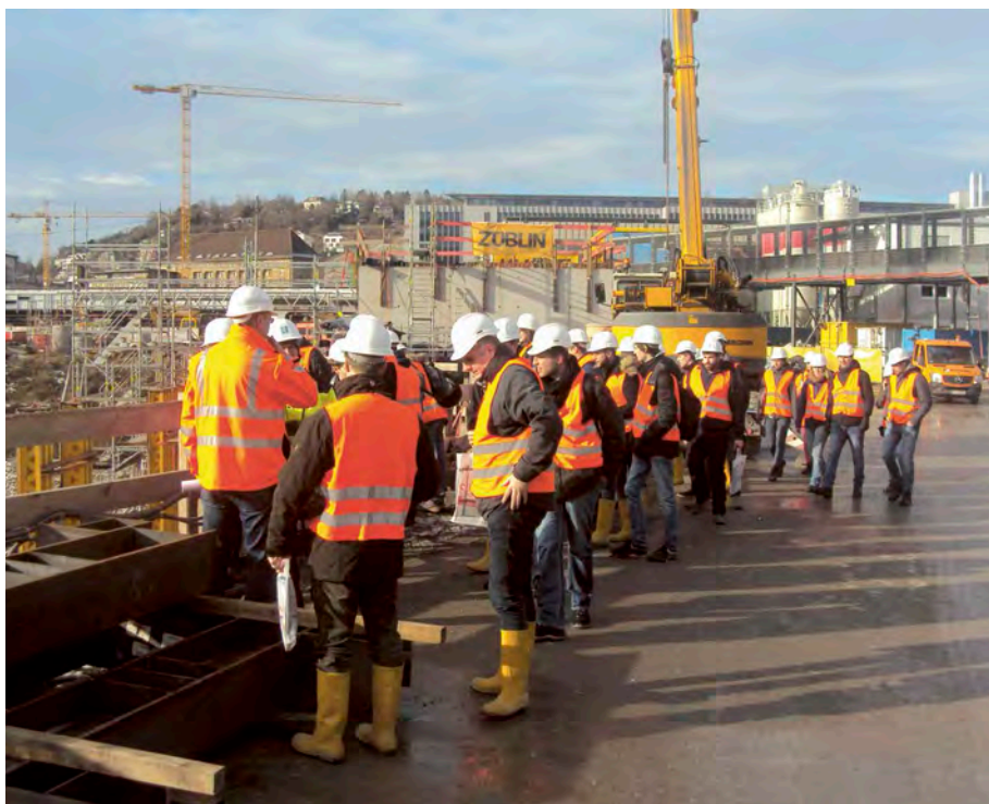
Reicher um praktische Erfahrungen: Die Studierenden des Fachbereichs Bauingenieurwesen der Hochschule Koblenz informierten sich bei einem Ortstermin über Stuttgart 21.
