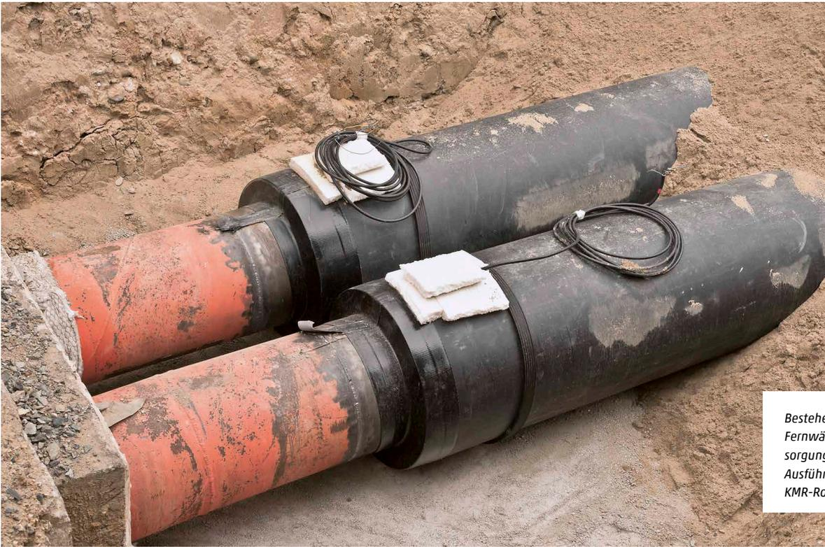
Bestehendes Fernwärmeversorgungsnetz: Ausführung als KMR-Rohr.
