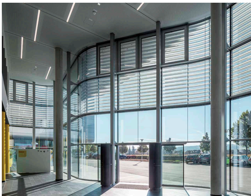
Der externe Sonnenschutz dient in erster Linie der Beschattung und somit dem Schutz vor Hitze und direkter Sonneneinstrahlung. Natürlich soll er auch optisch zum Gebäude passen.
