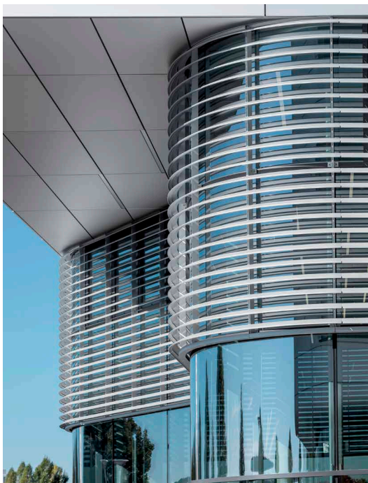
← ↑ Verdrehte Lamellen schaffen einen Sonnenschutz wie „aus einem Guss“
