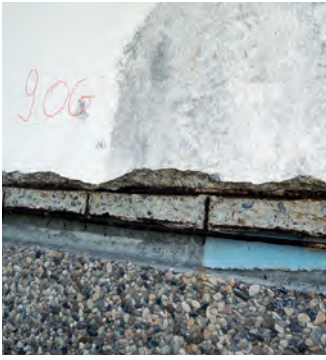
Die weitgehend zerstörten Tropfkanten der Wetterschutzschalen wurden bis zur ersten Bewehrungslage mechanisch entfernt und erneuert. Die gesamte Fläche erhält dann wie die Brüstungsplatten der Loggien ein Oberflächenschutzsystem Typ OS 4.
