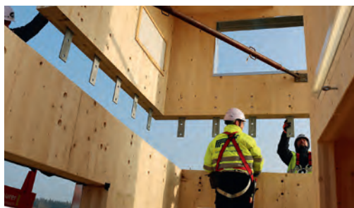
Schlösser Holzbau GmbH
