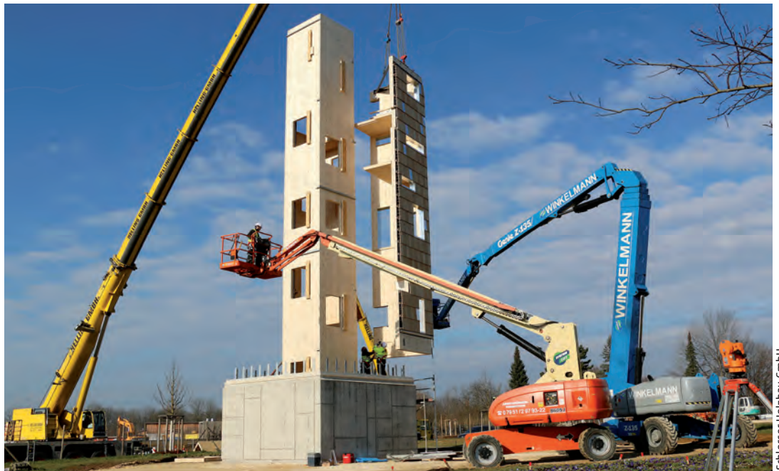
Schlösser Holzbau GmbH
