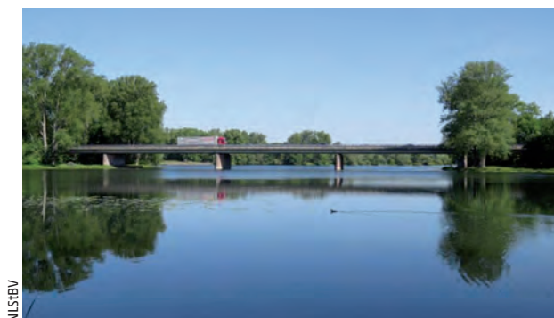
Abb. 3: Brücke über die Flutmulde der Leine im Landschaftsschutzgebiet der Auenlandschaft
