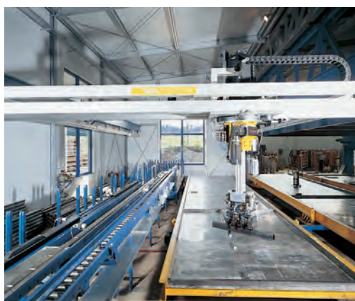
Der Schal- bzw. Entschalroboter im Einsatz
