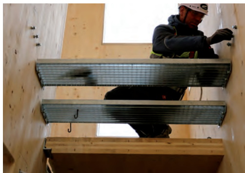
Schlösser Holzbau GmbH
