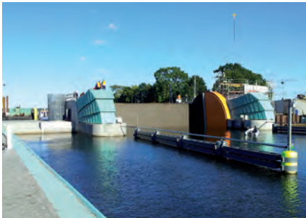
Das Sturmflutsperrwerk in der Hansestadt Greifswald wird mit dem Deutschen Ingenieurbaupreis 2016 ausgezeichnet.
