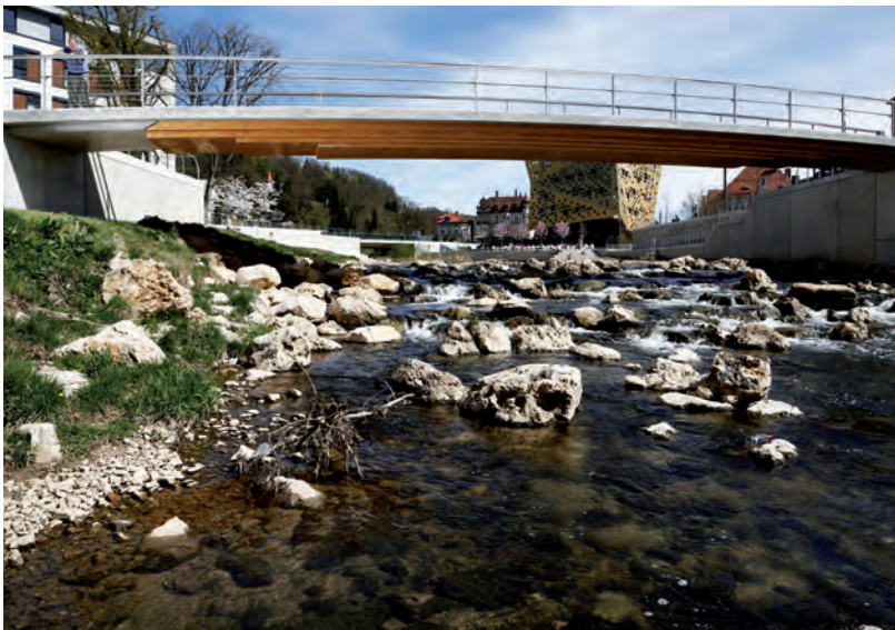
Die elegant gefügten integralen Holz-Beton-Verbundbrücken in Schwäbisch Gmünd zeichnen sich durch besondere Eleganz und Ästhetik aus.
