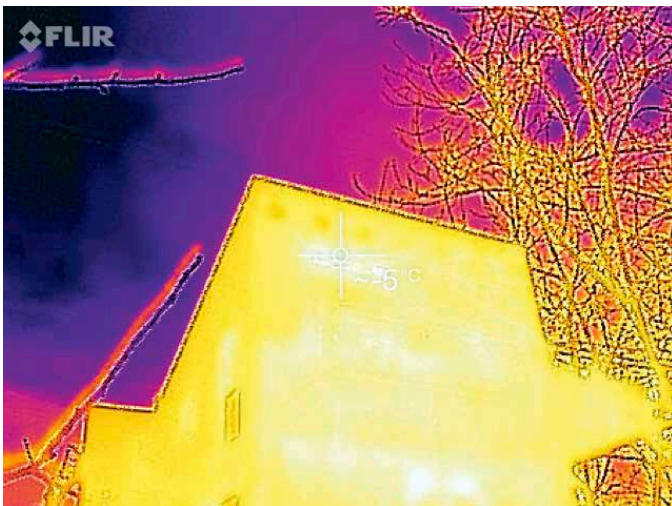
Abb. 5: Gartenseitige Westansicht des Mauerwerks des Nachbarhauses
