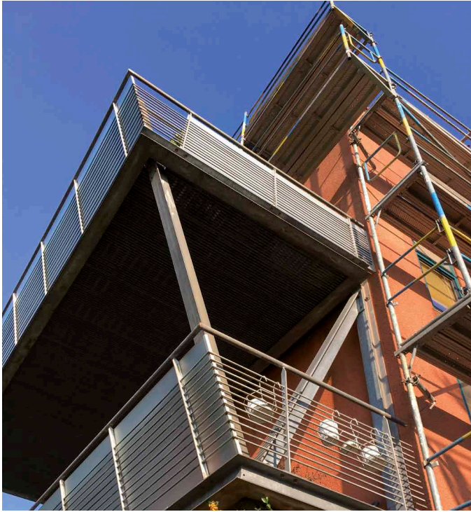
... SOLCHE MODERNE BALKONE ersetzt, die mit Wärmedämmverbundsystem und ihren optischen Vorteilen, nur etwas teurer waren, als die Sanierung der alten Balkone.
