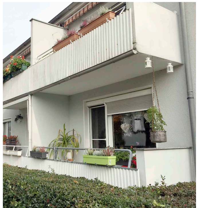
DIESE SCHWEREN BALKONKONSTRUKTIONEN, die ohne thermische Trennung von innen nach außen geführt worden waren; wurden, nach sorgfältiger Abwägung, durch ...
