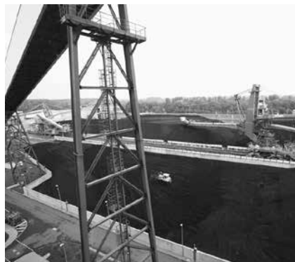
Der Kohlevorrat vor dem EnBW-Kraftwerk
