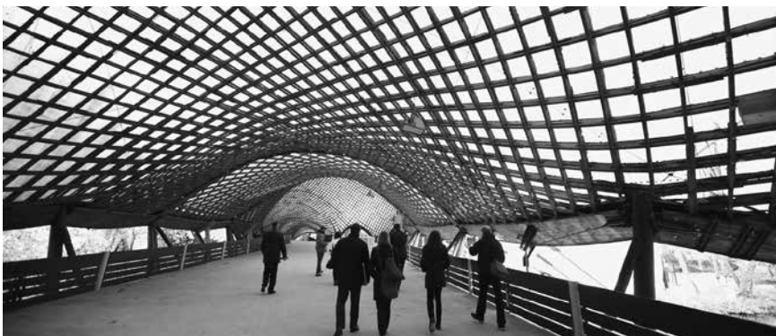
Die Multihalle Mannheim ist die größte Holzgitterkonstruktion der Welt.
