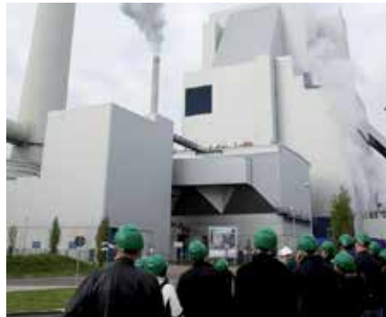
Die zweitägige Journalistenreise der Ingenieurkammern Baden-Württemberg und Rheinland-Pfalz startete am Steinkohlekraftwerk in Karlsruhe.
