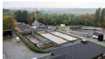
Die Kläranlage in Monsheim wird derzeit während des laufenden Betriebes energetisch saniert.
