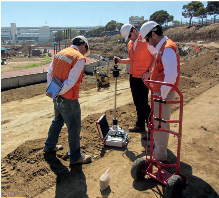
Beim Neubau des Fußballstadions in Valparaiso (Chile) wird die Tragfähigkeit der Zuwegung zur Qualitätssicherung mit dem Leichten Fallgewichtsgesetzgerät HMP LFG geprüft. (Gunnar Hennings (Mitte))
