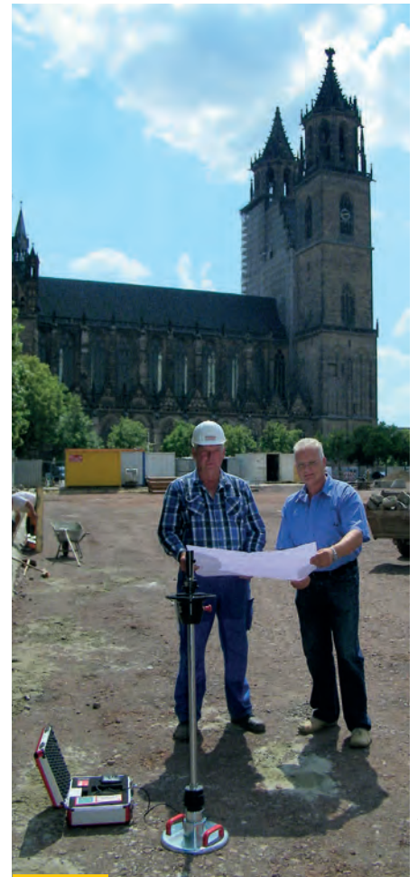
Einsatz des LFGpro für den Pflasterbau des Domplatzes in Magdeburg
