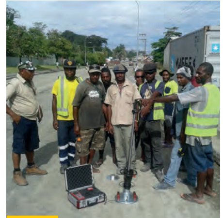
Praxistest des HMP LFGpro in Papua-Neuguinea, das dort zur Qualitätsüberwachung beim Bau neuer Straßen eingesetzt wird
