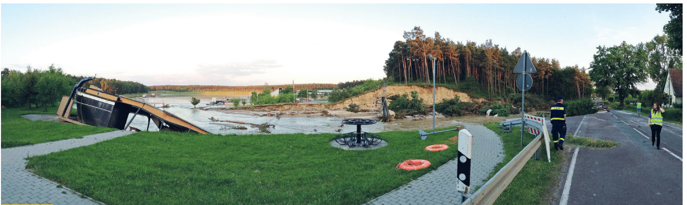
Flutbereich der Elbe – Schleuse Niegripp
