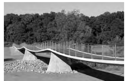
Foto: Ostansicht der Fußgänger- und Radwegbrücke,
