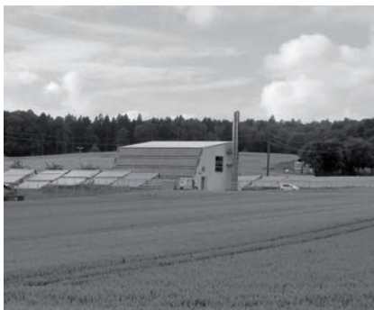
Heizwerk und Kollektorfläche im Energiedorf Bisingen
