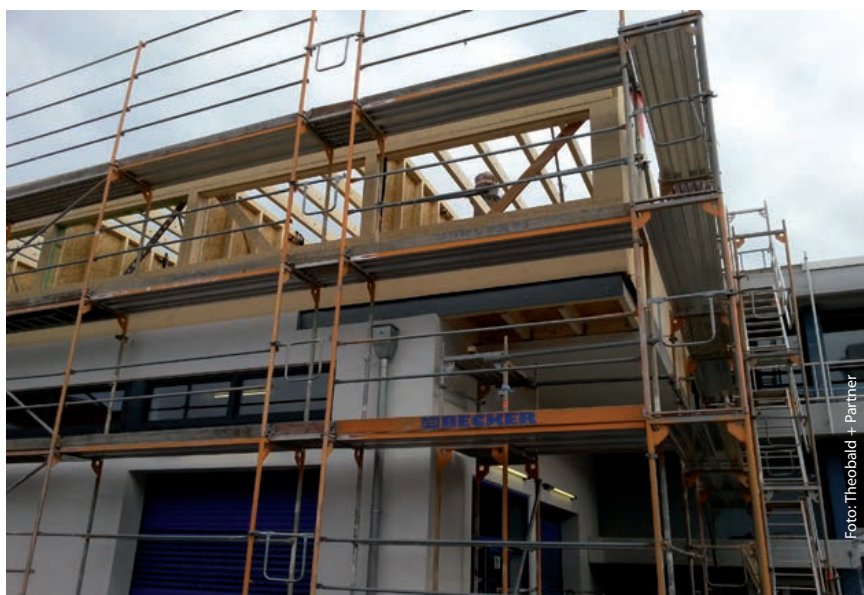
Aufstockung in Holzrahmenbauweise
