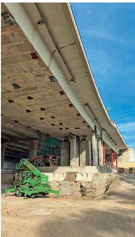
Der Abriss des Herzstücks der Schiersteiner Brücke soll bis Ende 2018 dauern. Die neue Brücke soll bis 2021 fertiggestellt sein und rund 216 Millionen Euro kosten.
