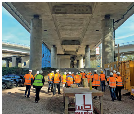
Ausgestattet mit Schutzhelmen und Warnwesten nahmen rund 20 Mitglieder an der Baustellenbesichtigung teil.
