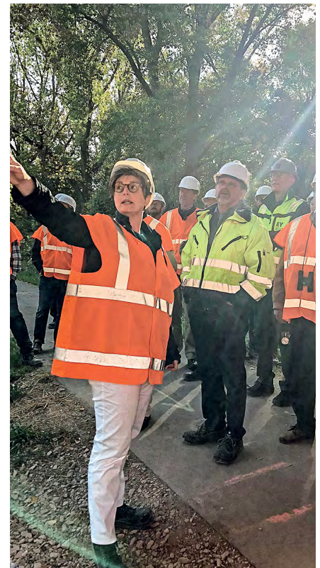
Dorothee Moßmann, Leiterin des Projekts Mainzer Ring vom Landesbetrieb Mobilität Rheinland-Pfalz (LBM), führte die Teilnehmer über die Baustelle.
