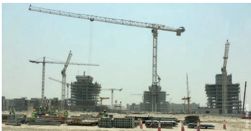
Mega-Baustelle Expo 2020 Dubai: Die Bauarbeiten sind bereits sich in vollem Gange
