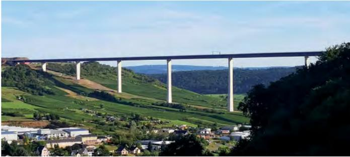
*In einer Höhe von rund 160 Metern wird sich die Hochmoselbrücke bei Zeltingen-Rachtig 1,7 Kilometer lang über das Moseltal spannen. Die Fahrbahn der Brücke ist so hoch, dass diese sogar den Kölner Dom überragen würde.*
