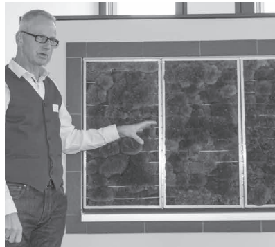
moosbasierte Bio-Tech-Fassade © BBIK
