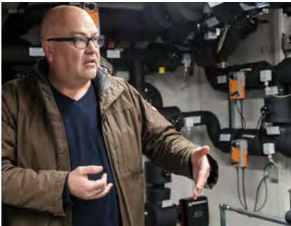
Dipl.-Ing. Alexander Klein (EWT-Ingenieure GmbH) weist auf die Besonderheiten bei der Konstruktion des Rechenzentrums hin.
