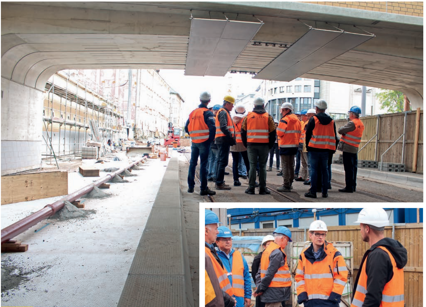
Projektleiter Christian Fuß erklärt die Bauabschnitte der Großbaustelle den Teilnehmern der Besichtigung
