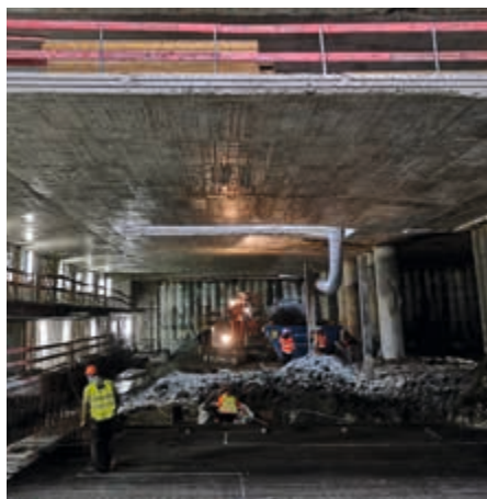
Bau von 520 Tiefgaragen-Stellplätze auf 3 Ebenen.
