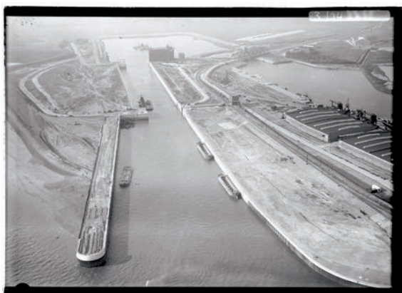
Die nahezu fertiggestellte Nordschleuse zeigt den Vorhafen mit der Westmole und der Ostkaje sowie dahinter die Schleusenkammer. Über dem Binnenhaupt wird noch das Reservetor montiert.
