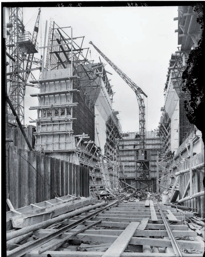
Die aus Stahlbeton hergestellten Torkammern, hier ein Bauzustand am 7. September 1929, sind knapp 20 m hoch.
