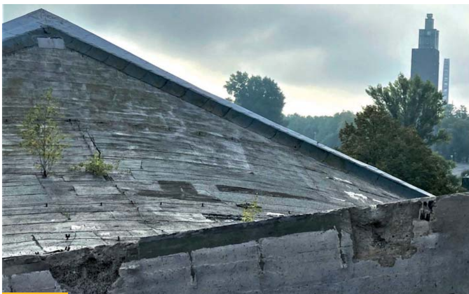
Einblick in die Dachsanierung aus nächster Nähe
