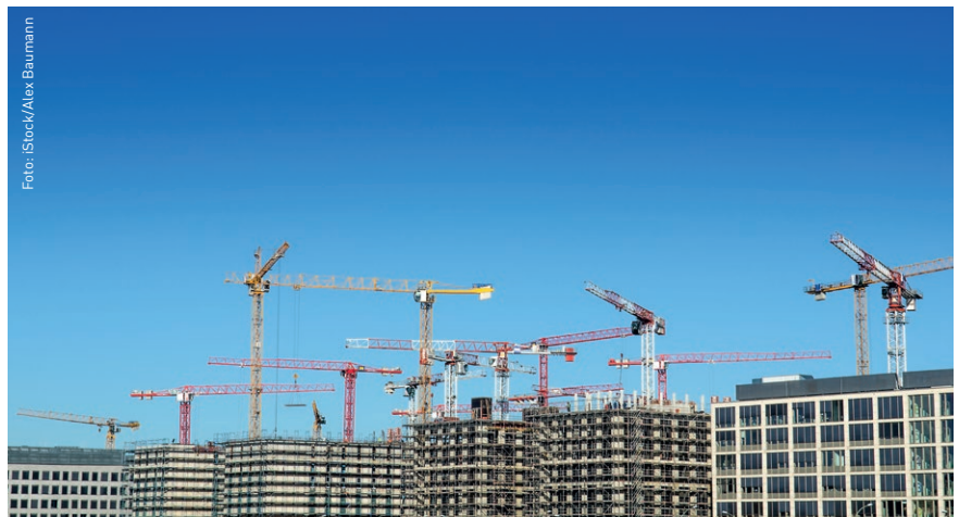
Auf den Baustellen kommt es vielerorts zu Lieferverzögerungen und Materialengpässen.
