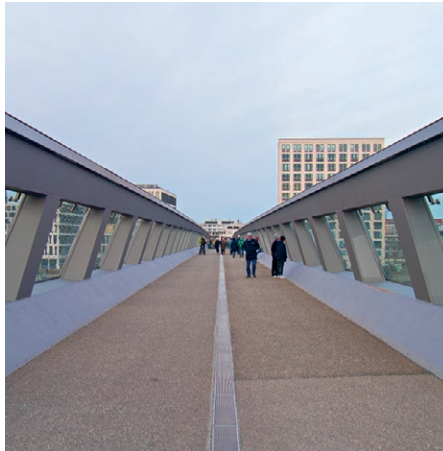
Der Münchner Arnulfsteg wurde im Dezember 2020 für den Fuß- und Radverkehr geöffnet.
