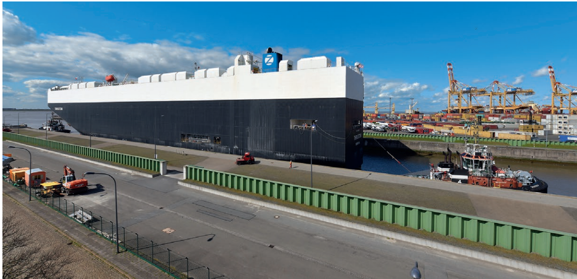
Die Nordschleuse ist auch nach 90 Jahren noch in vollem Betrieb.
