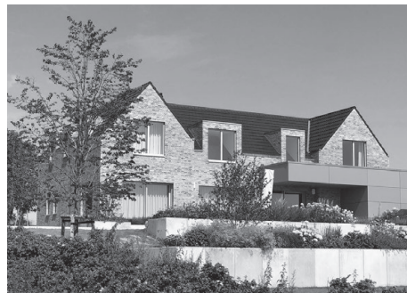
Neubau eines Einfamilienhauses, Ostenfeld
