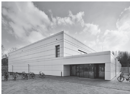
Energetische Sanierung und Modernisierung Dreifeldsporthalle, Schulzentrum Eilun-Feer-Skuul, Wyk auf Föhr
