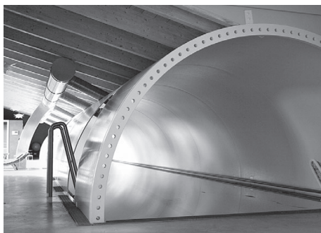
Schwimmbad in einem ehemaligen Turmsegment einer Windkraftanlage, Reußenköge
