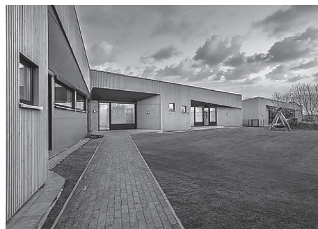
Wiederaufbau und Neubau Waldorfkindergarten und Waldorfschule, Wöhrden
