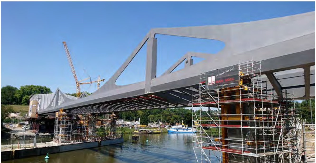
Die Baustelle zur neuen Neckarbrücke am Rosensteinpark am 31.07.2018
