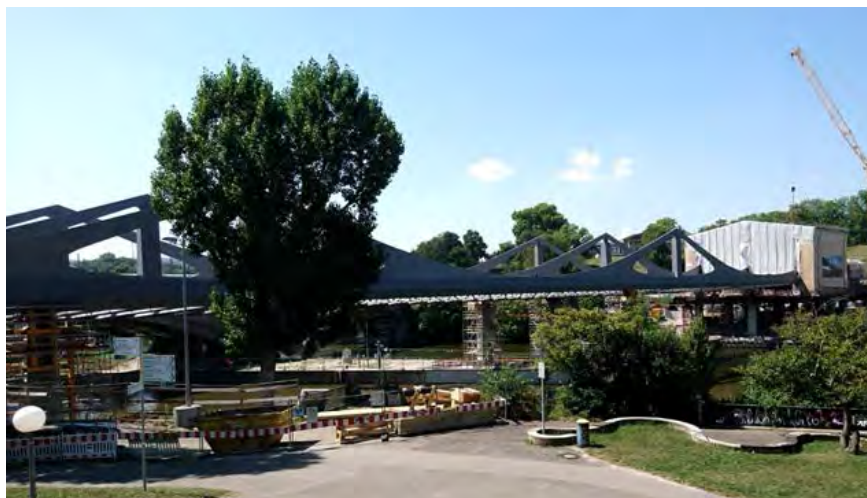
Die Baustelle zur neuen Neckarbrücke am Rosensteinpark am 31.07.2018
