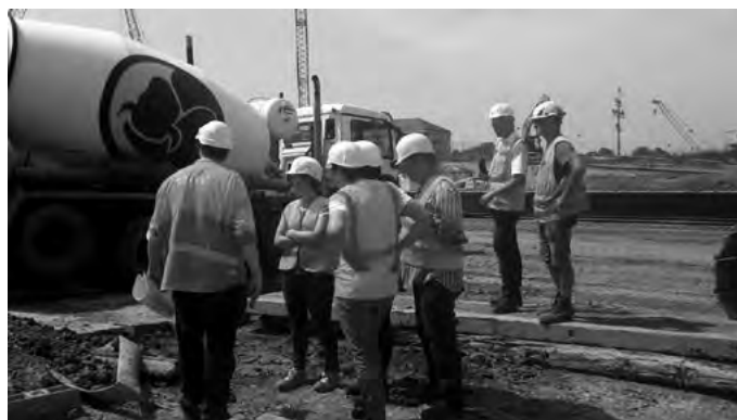
Betonarbeiten auf der Schleuseninsel.
