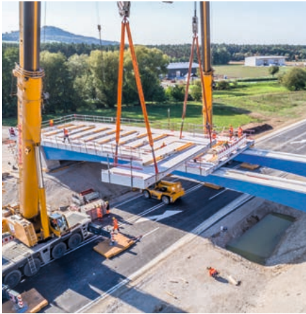
1. Preis: Pilotprojekt Segmentbrücke, Max Bögl, B299, Ortsumgehung Mühlhausen
