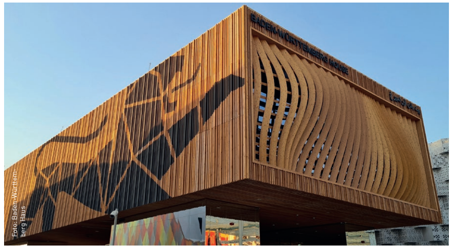
Die Fassade des Pavillons wurde aus Fichtenholz aus Baden-Württemberg konstruiert.
