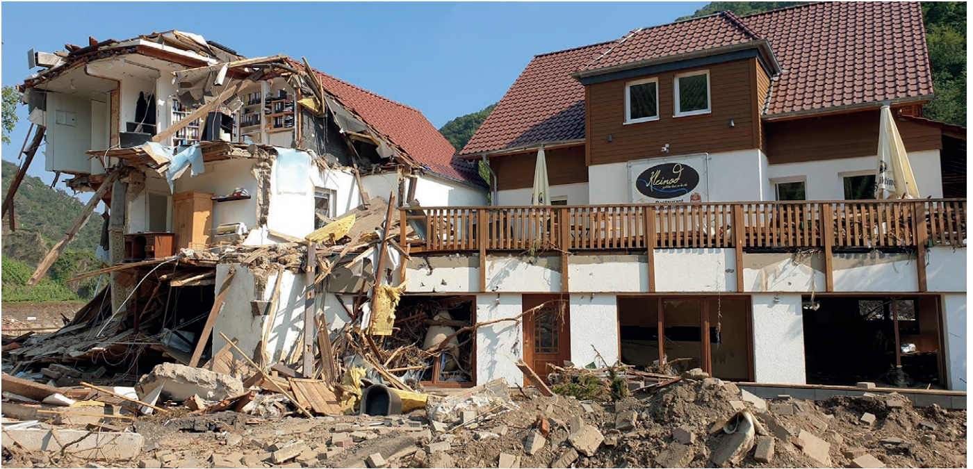
Haus mit willkürlicher Zerstörung in Marienthal
