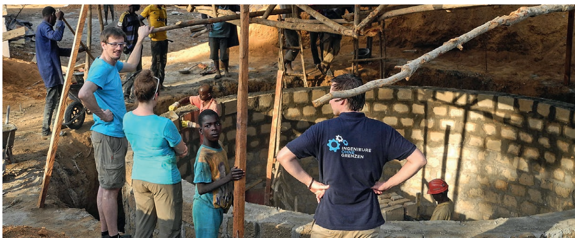
Der Bau einer Zisterne für die Dorfschule in Kanty in Guinea wurde von Ingenieure ohne Grenzen ermöglicht.
