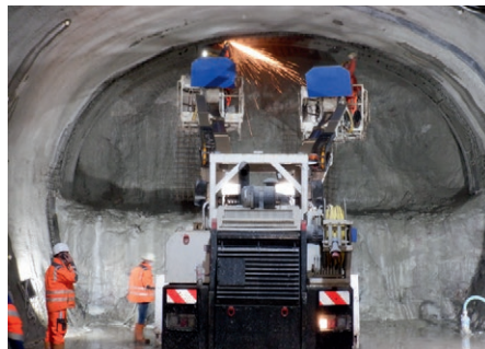
Arbeiten am Tunnel für die U3 in Nürnberg.
