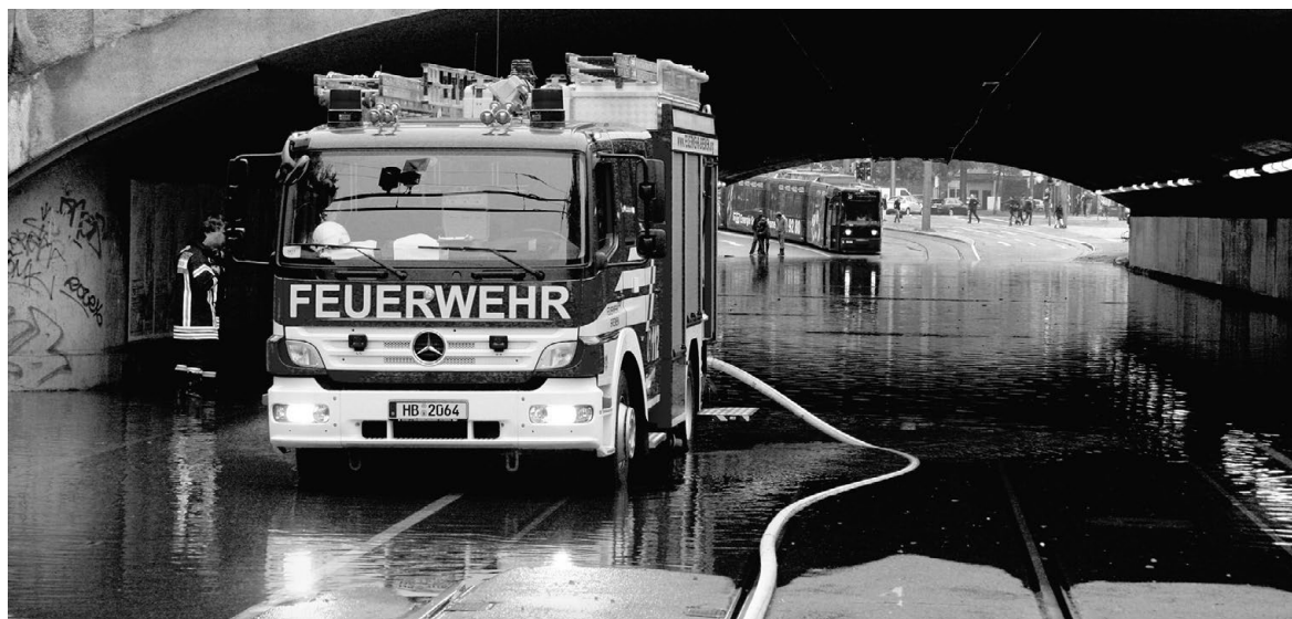
Abpumparbeiten nach einem Starkregenereignis im Gustav-Deetjen-Tunnel
