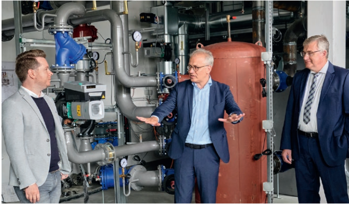
IngKH-Präsident Dipl.-Ing. Ingolf Kluge (rechts) und Staatsminister Tarek Al-Wazir (Mitte) lassen sich von Benedikt Leidorf (Abteilungsleiter Wärme- und Energiedienstleistungen bei der FRANK Projektentwicklung Rhein-Main GmbH, links) das Konzept des Eisspeichers erläutern.
