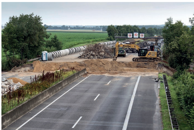
Reparaturarbeiten an der Autobahn A61 bei Swisttal, wo sie der Schiessbach beschaedigt hat.
