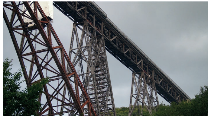
Detailaufnahme der Müngstener Brücke
