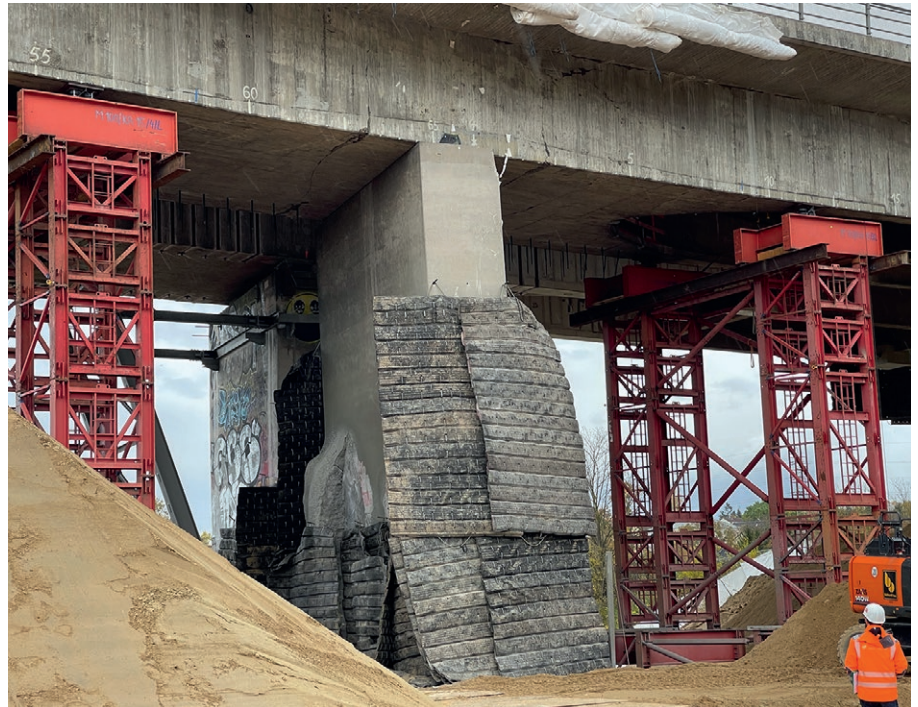
Pfeiler E mit Stütztürmen und Stützwällen-Detail
