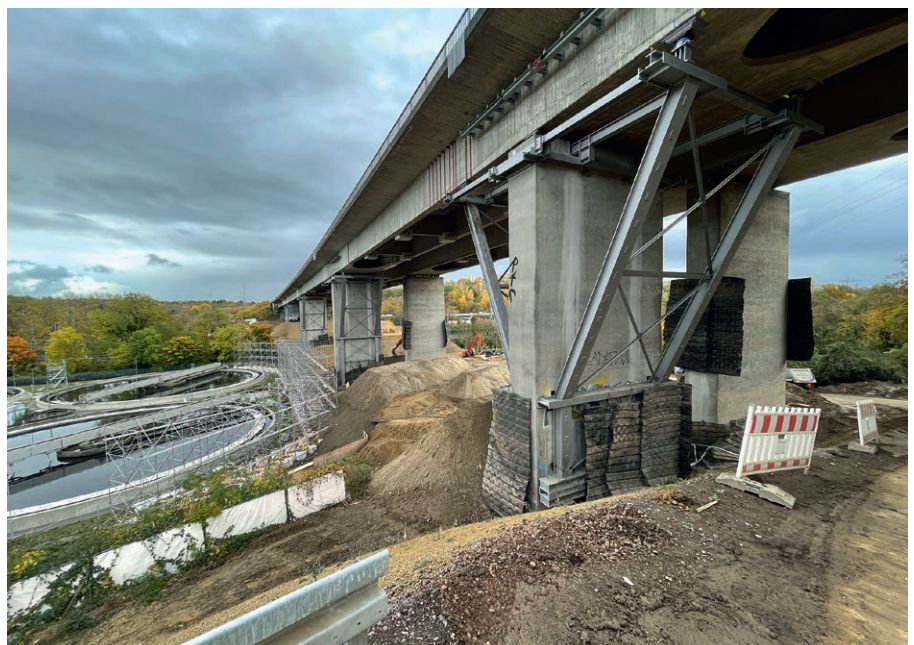
Gesamtansicht über Kläranlage
