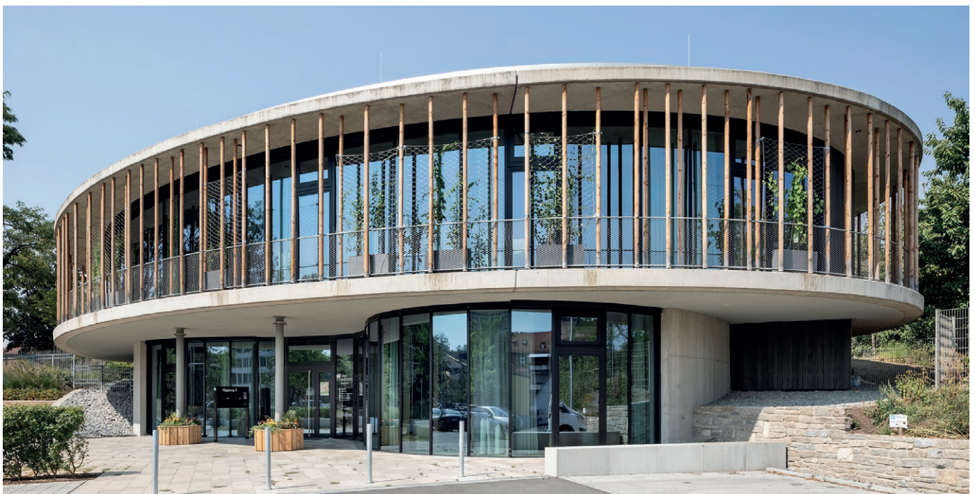
Umweltstation der Stadt Würzburg gebaut aus Recycling-Beton
