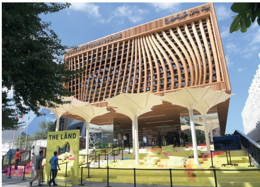
Die imposante Holzfassade des Baden-Württemberg Hauses wurde aus digital gefertigten Holzlamellen aus heimischer Fichte konstruiert (Foto: Erik Arazas)
