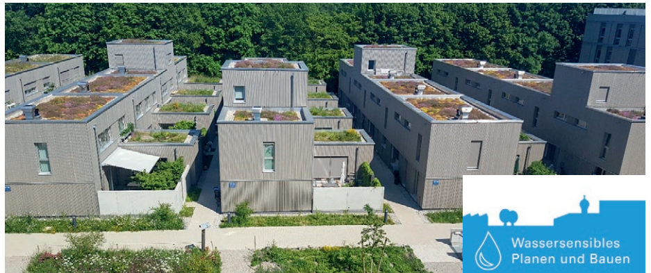
Ökologische Mustersiedlung in Holzbauweise: Prinz-Eugen Park München
