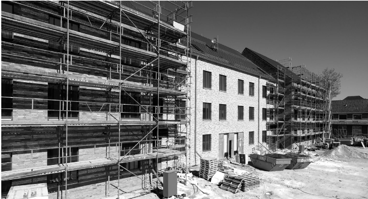
Baustelle Unterakunftsgebäude Marinestützpunkt Kiel
