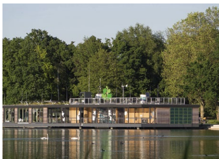
Die Energie- und Umweltstation am Wöhrder See in Nürnberg.
