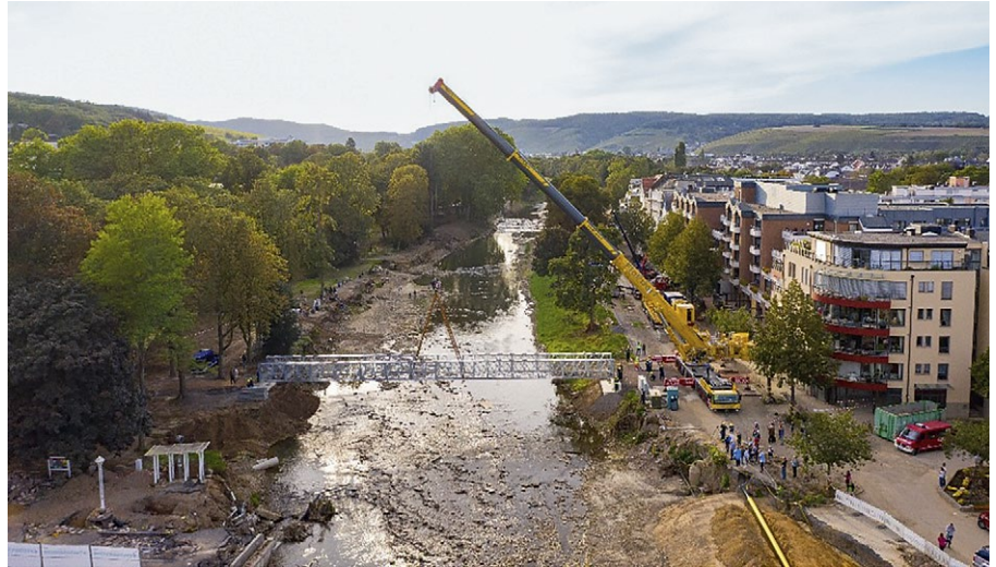
Insgesamt fünf Behelfsbrücken hat die Planung GmbH für die Stadt Bad Neuenahr-Ahrweiler über die Ahr projektiert - drei weitere sind in Planung.
