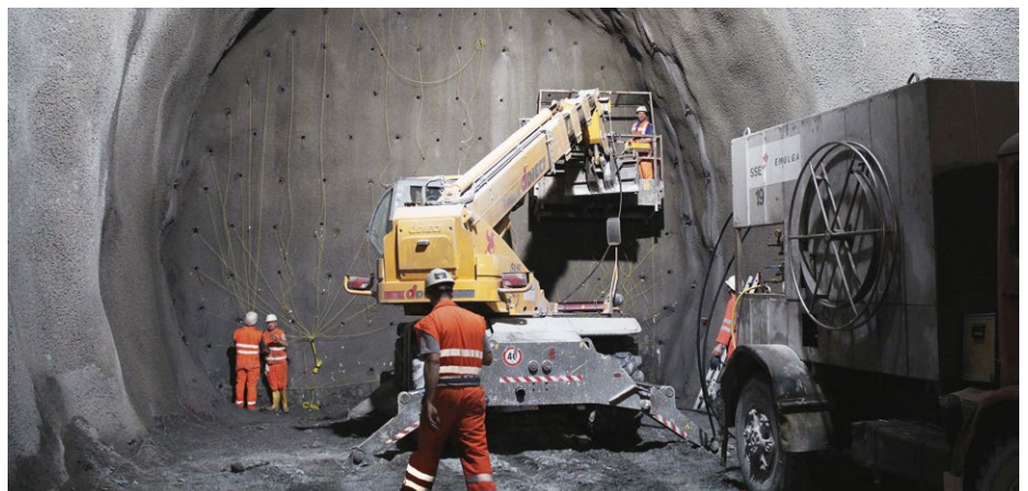
Die Arbeiten am Tunnel sind in vollem Gange.
