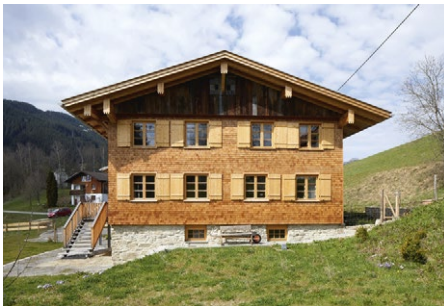
Gold - Private Bauwerke Wohnstallhaus - Nesselwang
