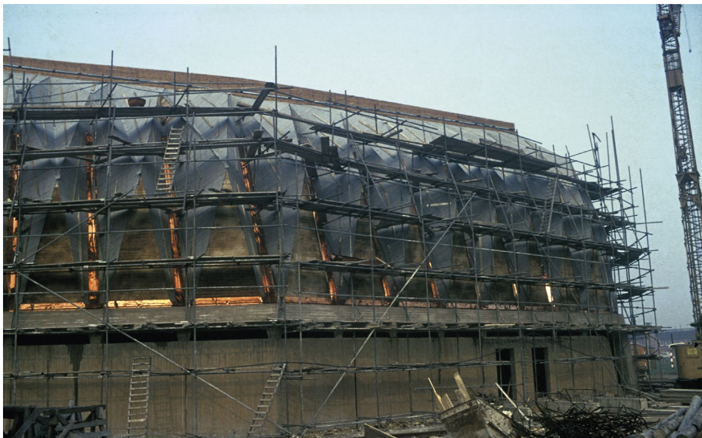
Kirche St. Paulus, Neuss, 1966/67, Architekt Fritz Schaller, Foto der Baustelle, o.D.
