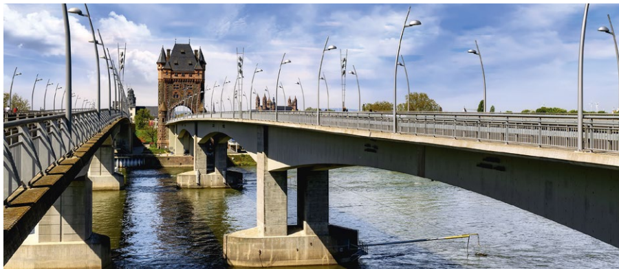
Die Nibelungenbrücke in Worms ist als erste Brücke weltweit im sogenannten Freivorbauverfahren entstanden.
